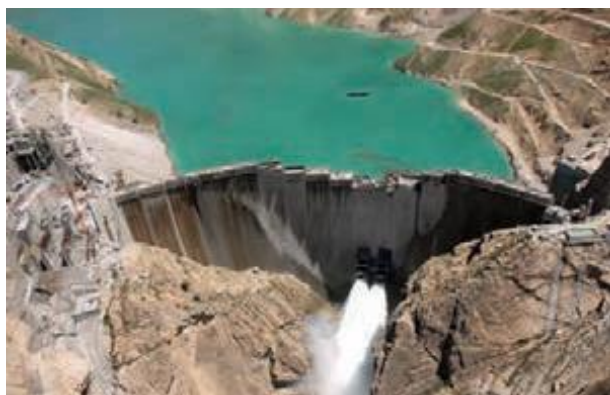
شکل ۷- سد کارون (۴) - خوزستان
