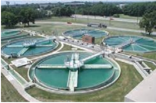
تصفیه آب در تصفیه خانه
