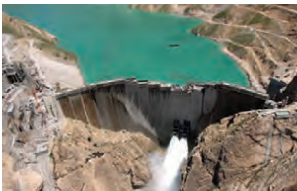
شکل ۷- سد کارون (۴) - خوزستان
